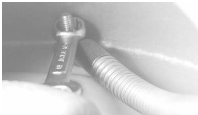
Figure 14 – Retrait du boulon de retenue du raccord flexible
