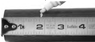
Figura 6A – Valiéndose de una cinta métrica, marque la profundidad hasta donde debe insertarse el tubo dentro del acoplador
