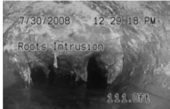
Figura 30 – Display en la pantalla muestra diapositiva superpuesta con texto, fecha, hora y distancia (medida desde el punto cero del sistema)
