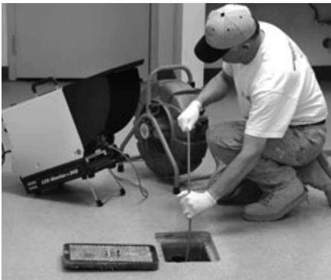
Figure 28 – Bonne technique de poussée du câble
