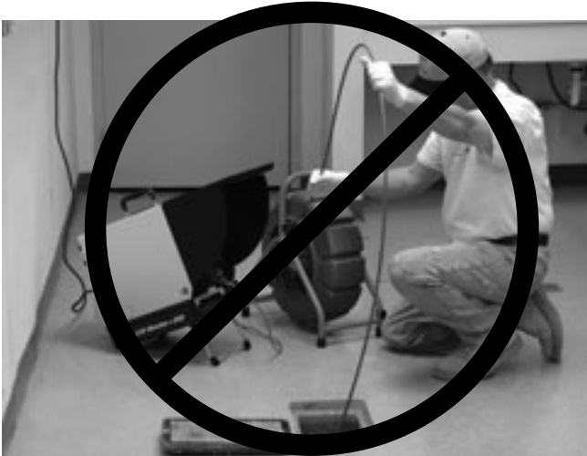
Figure 27 – Mauvaise technique de poussée du câble
