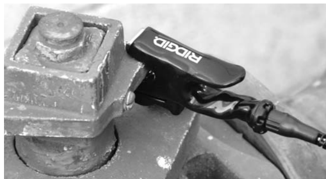
Figure 8 – Connexion du câble au conducteur ciblé.
