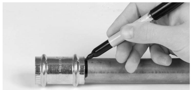
Figure 9 – Repérage du tuyau après insertion complète
